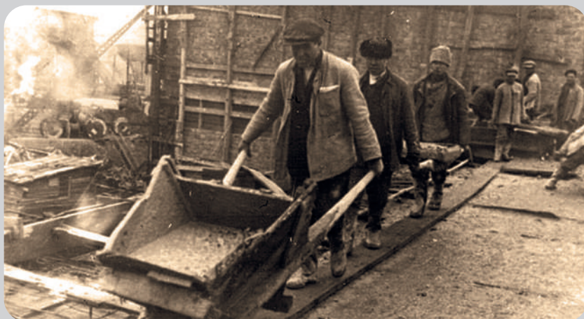
На будівництві ДніпроГЕСу
