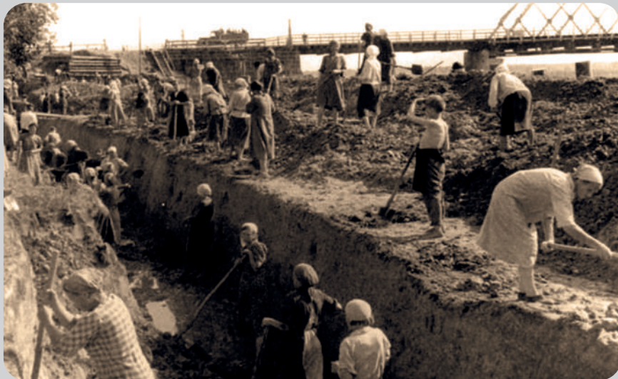
Будівництво протитанкових укріплень (1941 рік)
